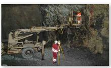
Die Achs- oder Profilkoordinaten von gemessenen Einzelpunkten können direkt vor Ort zur Bauwerkskontrolle angezeigt werden. Der automatische Scan von Bauwerksprofilen - auch unter Aussparung von bestimmten Bereichen, etwa mit Lutten - ermöglicht eine schnelle flächendeckende Kontrolle. Beim Scan erfolgt eine automatische Iteration auf die Stationierung und Bogenlänge.
