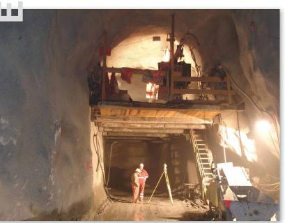
Flexibles Messen: Abstecken und Kontrollieren dort, wo es gerade gebraucht wird - mit Hilfe der analytischen Bauwerksgeometrie direkt auf der Totalstation.
