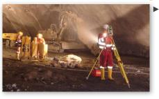
Die Positionierung der Totalstation erfolgt mit Leica Standardfunktionen. Anschließend werden Bezugspunkte für die Lage und Höhe des Standpunktes sowie die Orientierungsberechnung im Büro gemessen. Die Punktnummernzuordnung oder das Anfahren der Zielpunkte kann automatisch erfolgen.
