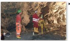
Die Bauwerksgeometrie wird aus der Büro-Software Axis3D COS auf die Totalstation exportiert. Die Absteckung von Punkten wird vor Ort mit Axis3D ETU relativ zur Bauwerksgeometrie vorgenommen, durch Angabe von Stationierung, Quer- oder Hochabstand von der Achse, Profilbogenlänge oder Radialabstand vom Regelprofil. Die Durchstoßpunkte von Raumgeraden durch die Bauwerksgeometrie können ebenfalls ermittelt werden.
